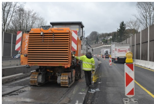
Bild 4: Großfräsen werden üblicherweise von 2er-Teams bedient. Für die Person am Boden muss ein Arbeitsraum mit einer Mindestbreite B_M = 80 cm neben der Maschine vorgesehen werden.
