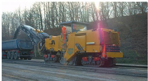
Beim Fräsen der ca. 4 cm dicken Deckschicht arbeiten sich 2-m-Fräsen mit einer Geschwindigkeit von rund 15 m/min durch den Belag. Damit befüllen sie einen 4-Achs-Lkw in nur 3 - 4 Minuten.
