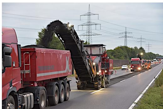
Beim selektiven Fräsen arbeiten die Kaltfräsen präzise im Millimeter-Bereich wie hier beim Abtrag einer Deckschicht.
