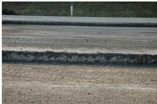
Lagenweises Fräsen: Im Vordergrund ist die Oberkante des ungebundenen Oberbaus zu erkennen, in der Mitte der Fahrbahn wurden bereits Deck- und Binderschicht abgefräst. Im Hintergrund ist das Asphaltaket noch komplett.
