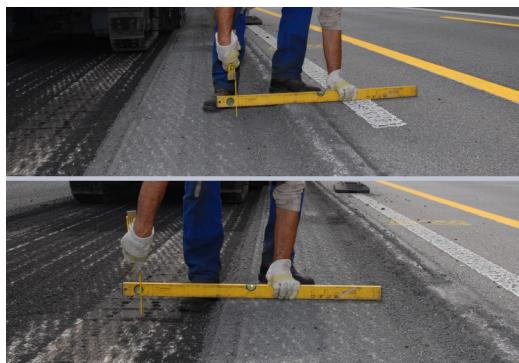
Die 4 cm dicke Deckschicht und die 8 cm starke Binderschicht wurden hier in zwei Arbeitsschritten separat gefräst.
